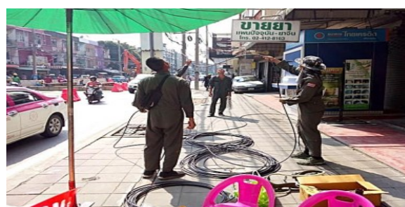
รูปที่ 17 นำสายลงจากเสา
