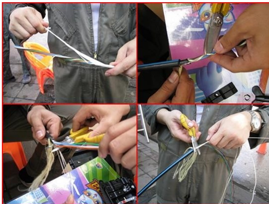
รูปที่ 21 ตัดเชือกหุ้มหลอด
