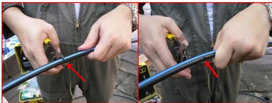
รูปที่ 18 ใช้คีมตัดทำรอยควั่น
