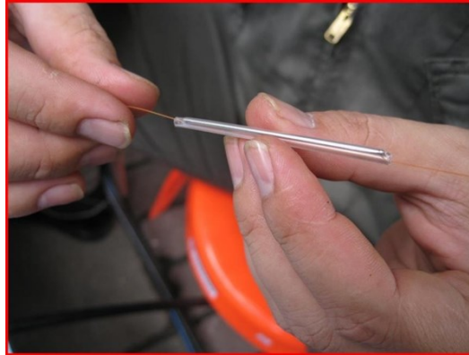
รูปที่ 31 ใส่ท่อหุ้มจุดต่อแกนใยแก้วนำแสง
