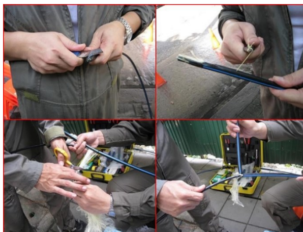
รูปที่ 19 ตัดเปลือกสายภายนอกออกไป
