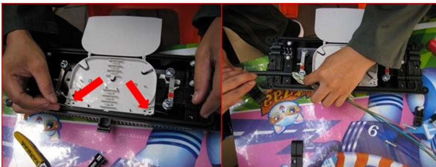
รูปที่ 22 นำเข็มขัดรัดสาย
