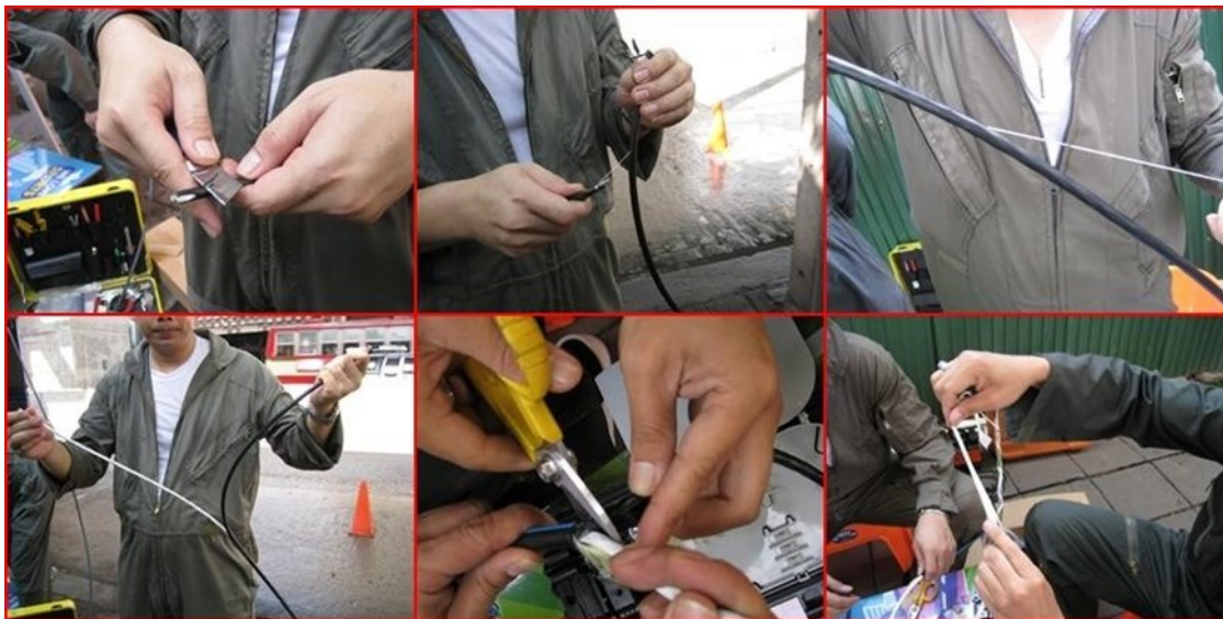
รูปที่ 20 ทำการปกสายภายในชั้นที่สอง
