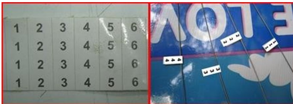
รูปที่ 28 ใช้สติ๊กเกอร์หมายเลขติดที่แกนใยแก้วนำแสง
